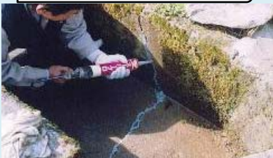
水路のひび割れ補修
