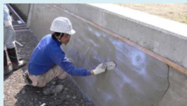
老朽化した水路壁のコーティング
