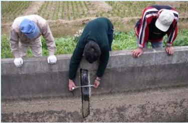
施設の機能診断
