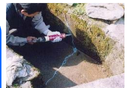
水路のひび割れ補修
