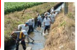
水路の泥上げ
