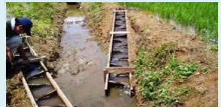
水田魚道の設置
