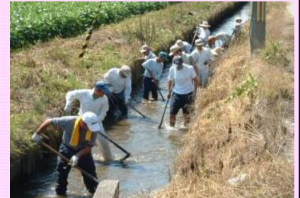
水路の泥上げ
